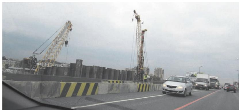
Первым делом на объекте стали обустроить буронабивные сваи опоры № 7 правого направления. Параллельно с ними продолжается сооружение строительного городка в районе пр. Народного Ополчения и ул. Авангардной, ведутся работы по подготовке территории строительства, а также выполняется устройство шпунтового ограждения для опор
